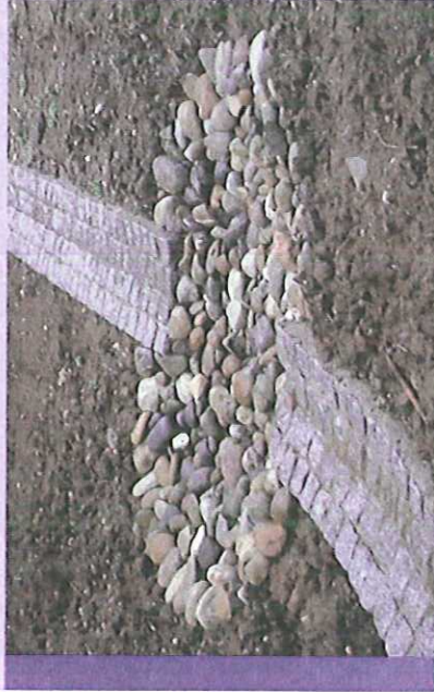
Beispiel für eine Versickerungsanlage
